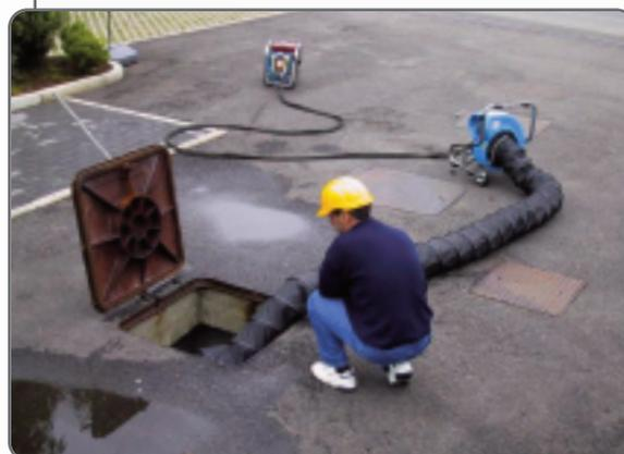
Pratico ventilatore/ aspiratore centrifugo carrellato con motore idraulico, potente ed è facilmente trasportabile il suo impiego è obbligatorio per legge per la messa in sicurezza prima e durante lavori in ambienti chiusi che potrebbero essere pericolosi o esplosivi come tunnel, scantinati, camerette, silos, stive, serbatoi, cunicoli, pozzi, impianti petrolchimici, distributori di carburante, magazzini chimici, miniere, laboratori, scavi angusti, condotti fognari, reti distribuzione gas etc.
