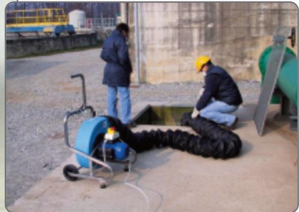
Pratico ventilatore/ aspiratore centrifugo carrellato con motore monofase 230 V, potente e e facilmente trasportabile il suo impiego è obbligatorio per legge per la messa in sicurezza prima e durante lavori in ambienti chiusi che potrebbero essere pericolosi o esplosivi come tunnel, scantinati, camerette, silos, stive, serbatoi, pozzi, cunicoli, impianti petrolchimici, distributori di carburante, magazzini chimici, miniere, laboratori, scavi angusti, condotti fognari, reti distribuzione gas etc.
